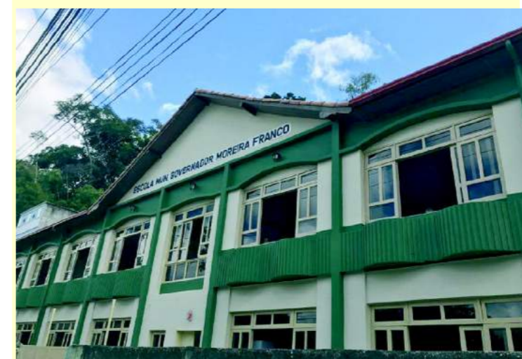
O antes e o depois da fachada da Escola M. Moreira Franco, em Bom Jardim.
